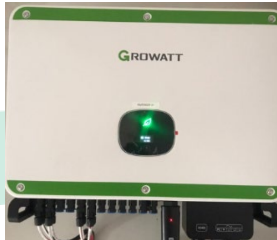
Teste de funcionamento dos Inversores
